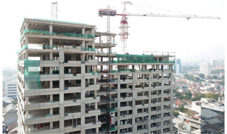
2. Pengangkatan menggunakan tower crane
