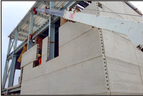
HCW - Pabrik Kewalram, Bandung
