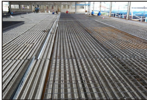
Half Slab - Pabrik Kopo, Bandung
