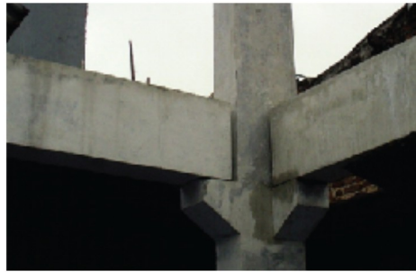
Balok & Kolom Precast
