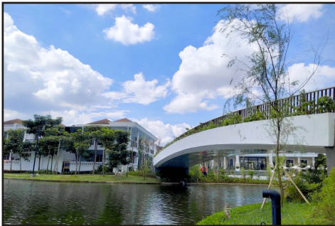
Pile - Podomoro Park, Bandung
