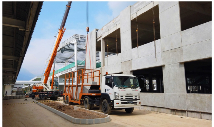
1. Pengangkatan menggunakan mobil crane
