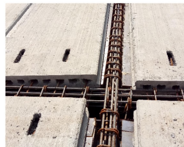
Peletakan HCS di tumpuan samping
